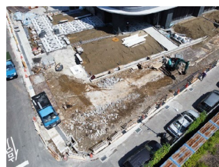
施工前底土夯實
