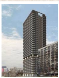
昇陽國際 ONE 360 (整建住宅)
