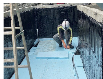
RF 花台牆內 PS 版施作
