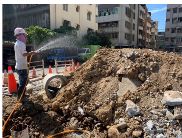
堆料棄土區灑水噴霧
