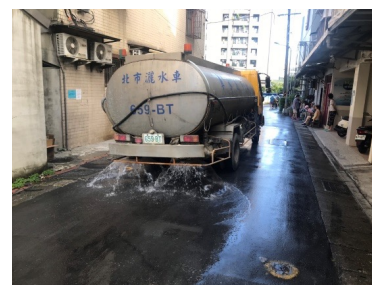
工地車行路面灑水噴霧
